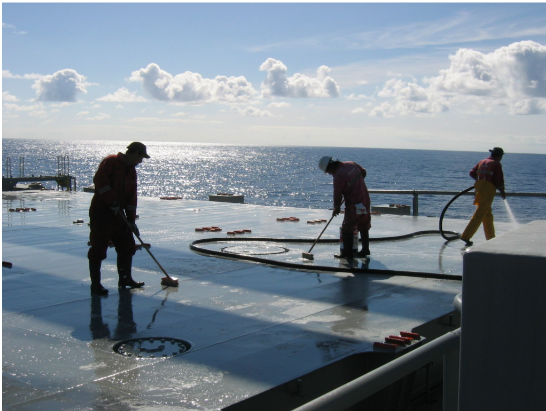
Abb. 7.1 Arbeiten an Deck
